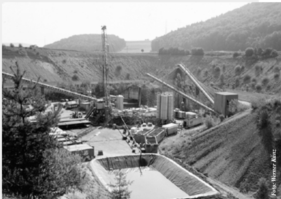
Gesamtansicht der Versuchsbohrung Weiach
